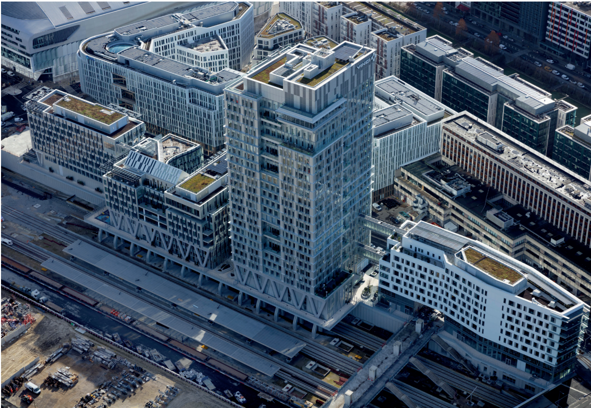
« L'archipel », le nouveau siège de VINCI à Nanterre, est un concentré des savoir-faire et des innovations du Groupe en matière de décarbonation des bâtiments.
