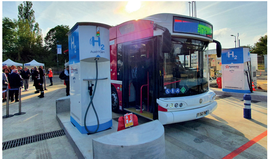
Inauguration de la station d'avitaillement des bus à hydrogène de la ville d'Auxerre dans le cadre du projet AuxHYGen (octobre 2021).
