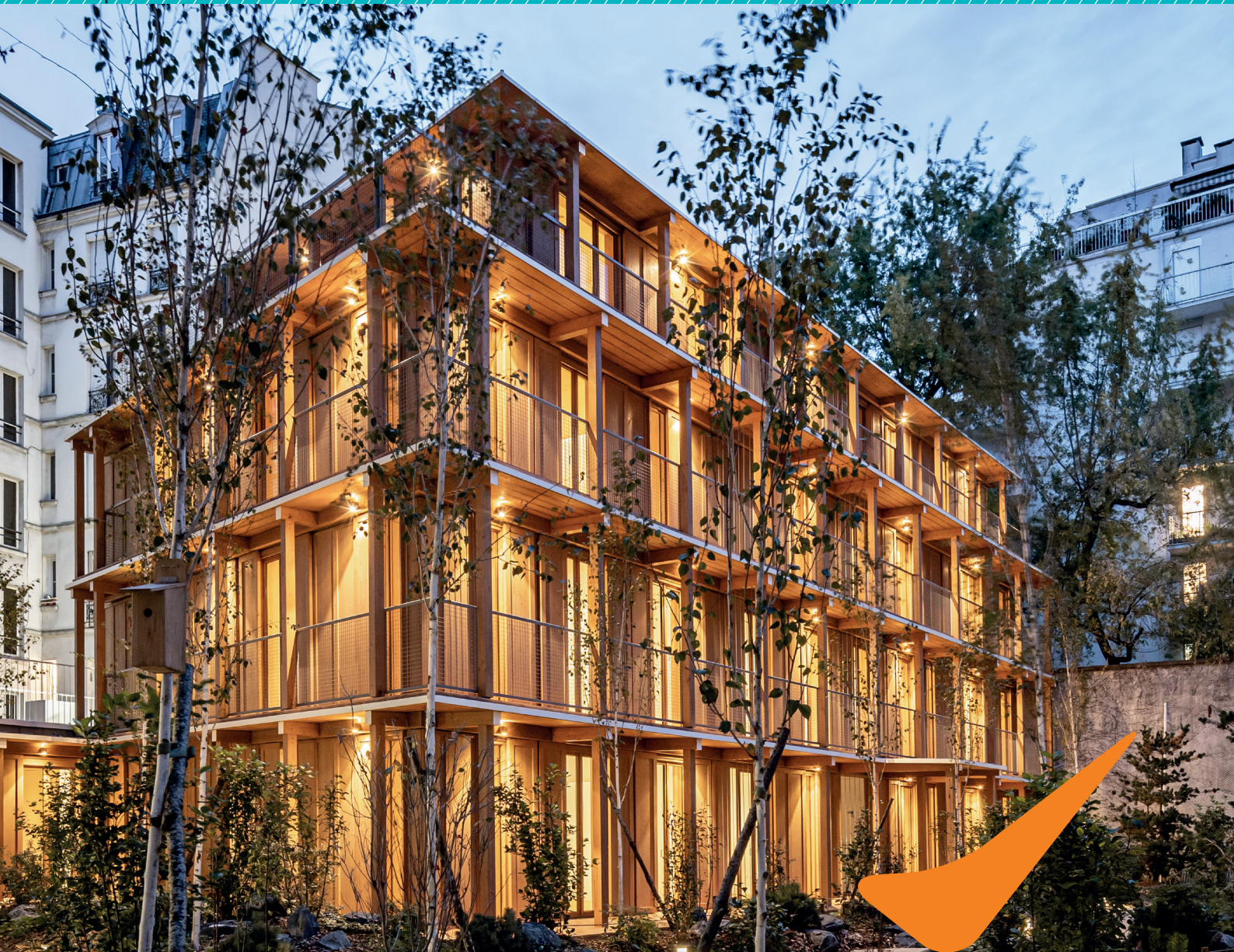
Immeuble à Saint-Mandé. © Nicolas Grosmond
