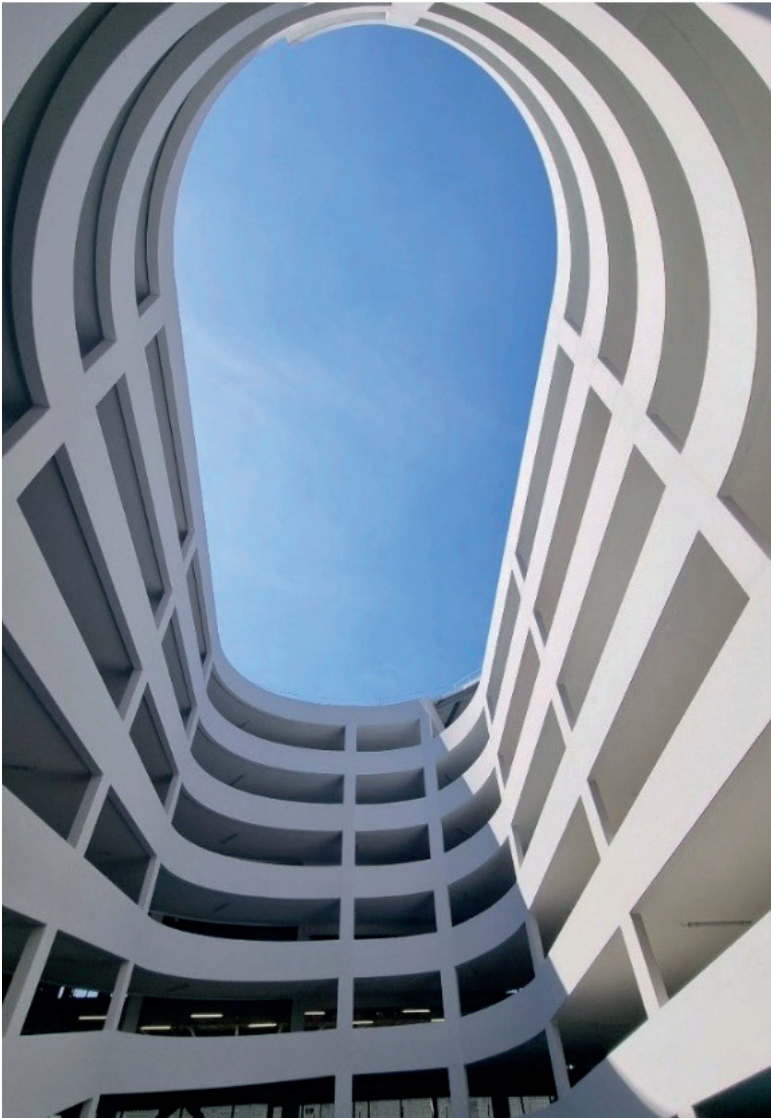
Vue de l'extérieur du parking P3.
