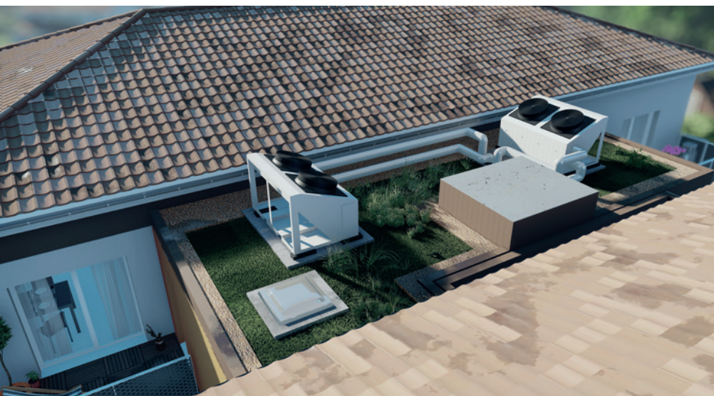
Fig. 3 : Programme Genas-Arcole Développement. 33 logements. Produits ZÉPAC chauffage et ECS centralisés. © Groupe intuis.
